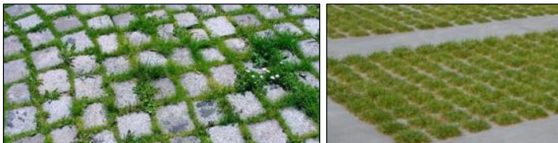
Ex. de traitement de sol limitant l'imperméabilisation
